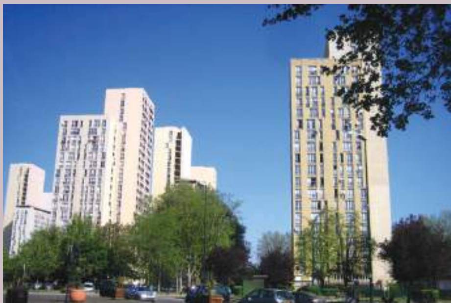
Place du 14 juillet à Vigneux-sur-Seine, les 7 tours IGH. Place du 14 juillet, Vigneux-sur-Seine, the 7 high-rise blocks.
