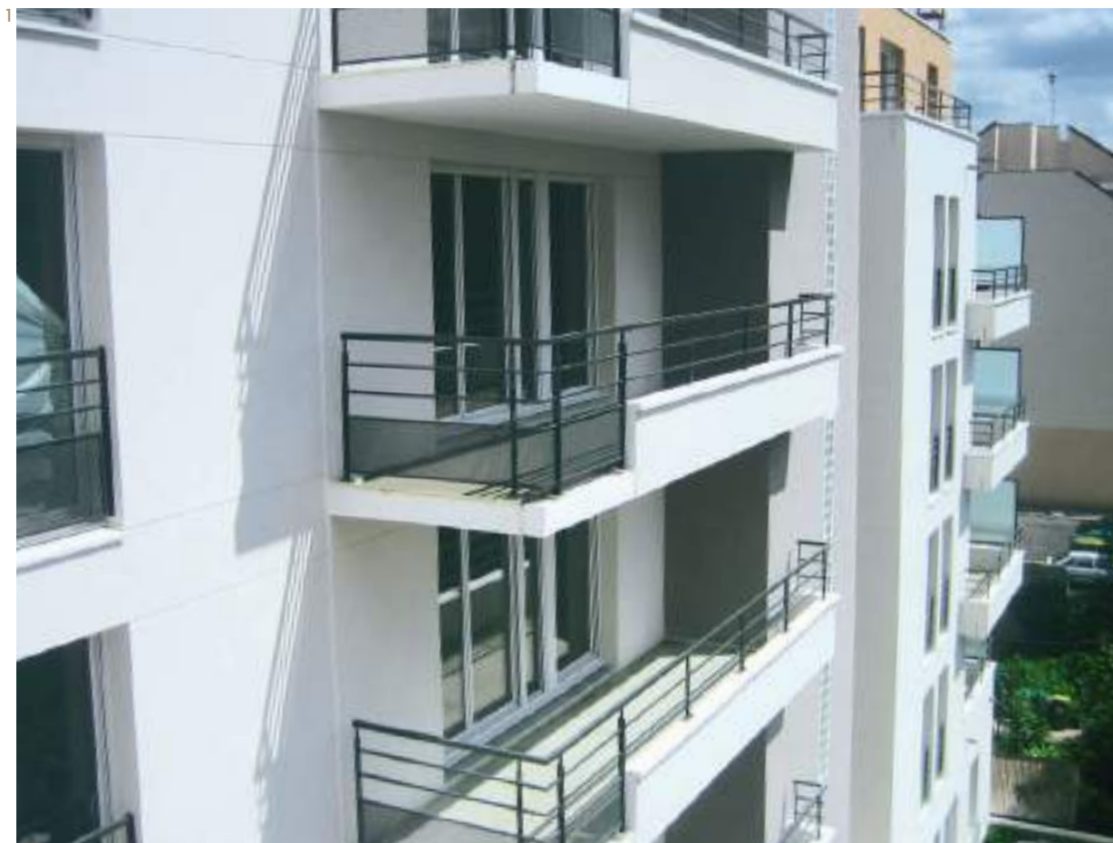
1] Détails de la façade et des terrasses-balcons. Details of the facade and the terraces / balconies.
